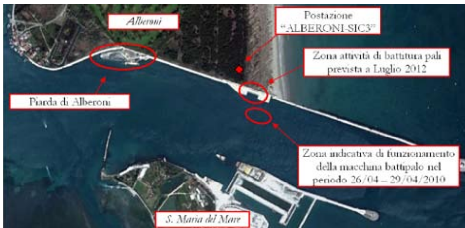
13. Individuazione della postazione di misura ALBERONI-SIC3 e delle zone in cui sono presenti le attività di cantiere, alla bocca di porto di Malamocco.
