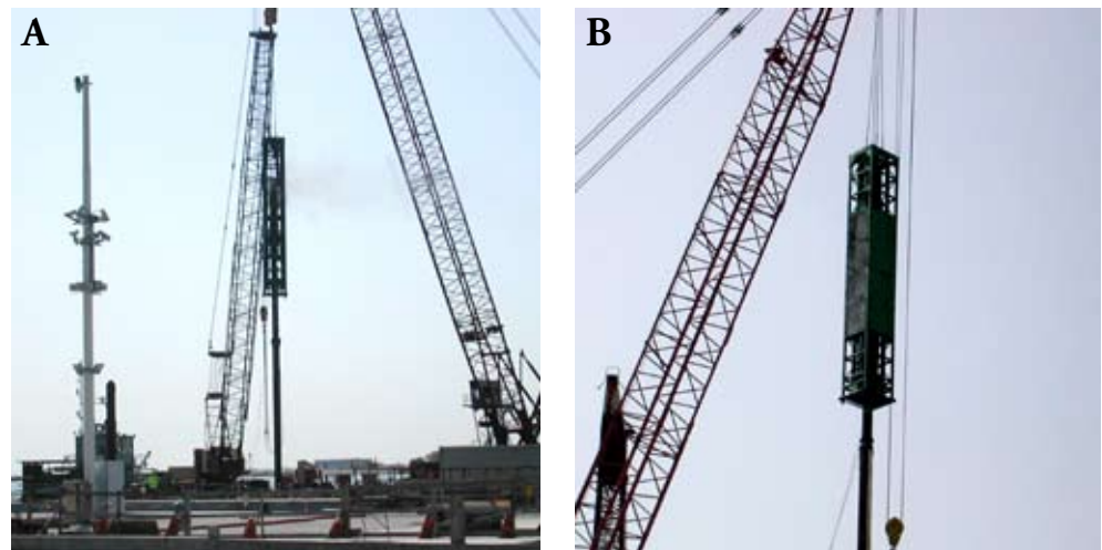
31. Foto della macchina battipalo prima (A) e dopo (B) l'installazione della schermatura acustica. Foto scattate, rispettivamente, in data 29 agosto e 11 settembre 2008 presso la bocca di porto di Chioggia.
